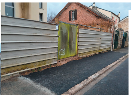
Réfection du trottoir rue Gambetta
